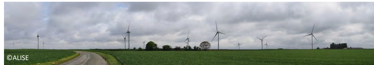
Photo 33 : Vue du parc éolien de la Sablière (premier plan) et deux éoliennes du parc éolien Champs perdus (deuxième plan)
