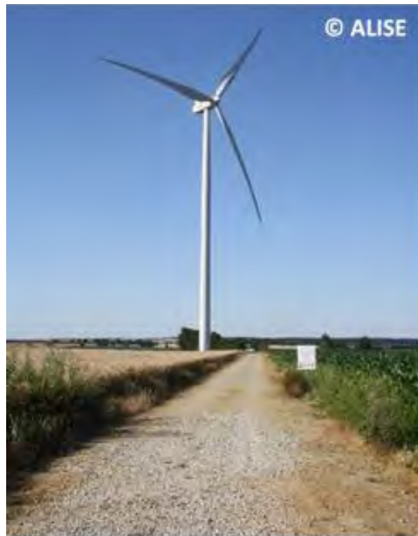
Photo 2 : Exemple de piste d'accès à une éolienne
