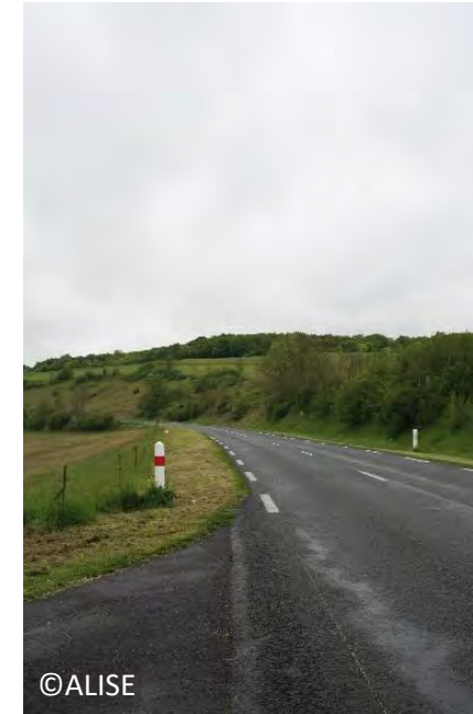
Photo 20 : Route départementale D935
