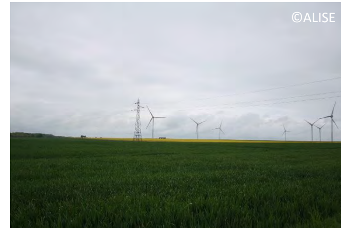
Photo 23 : Ligne électrique de 63 KV « Hargicourt – Roye » gérée par RTE
