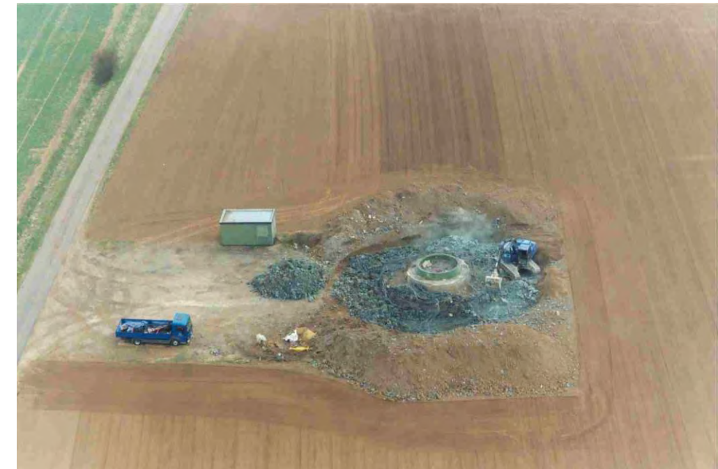
Photo 47 : Exemple de démontage de la plateforme et des fondations d'une éolienne
