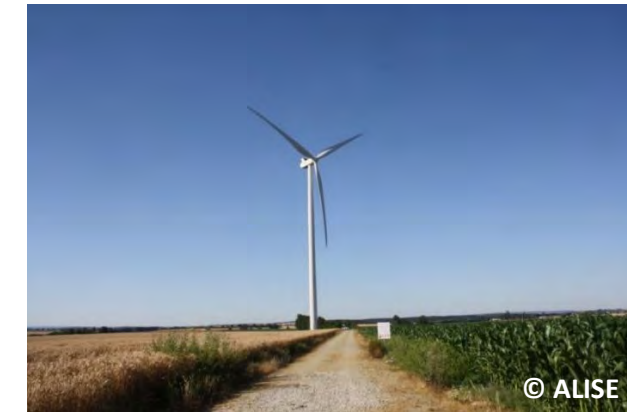
Photo 53 : Piste d'accès d'une éolienne
